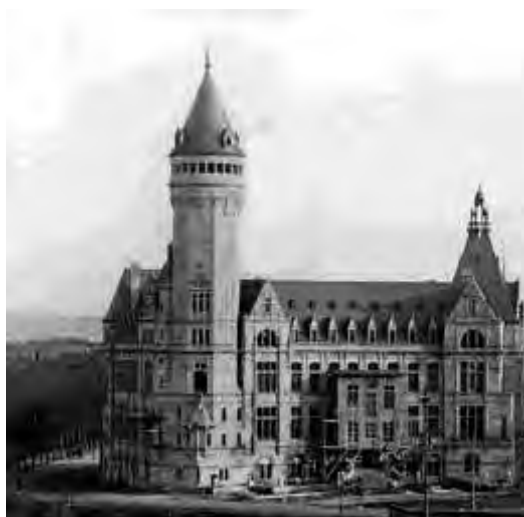
Wegen der durch die Rundstedt-Offensive wieder von amerikanischen Soldaten belegten Athenäumsgebäude fanden von Mitte Januar bis Ende März manche Klassen, auch meine VI e lat. A, Unterkunft auf dem Dachboden der Sparkasse nahe der Neuen Brücke
